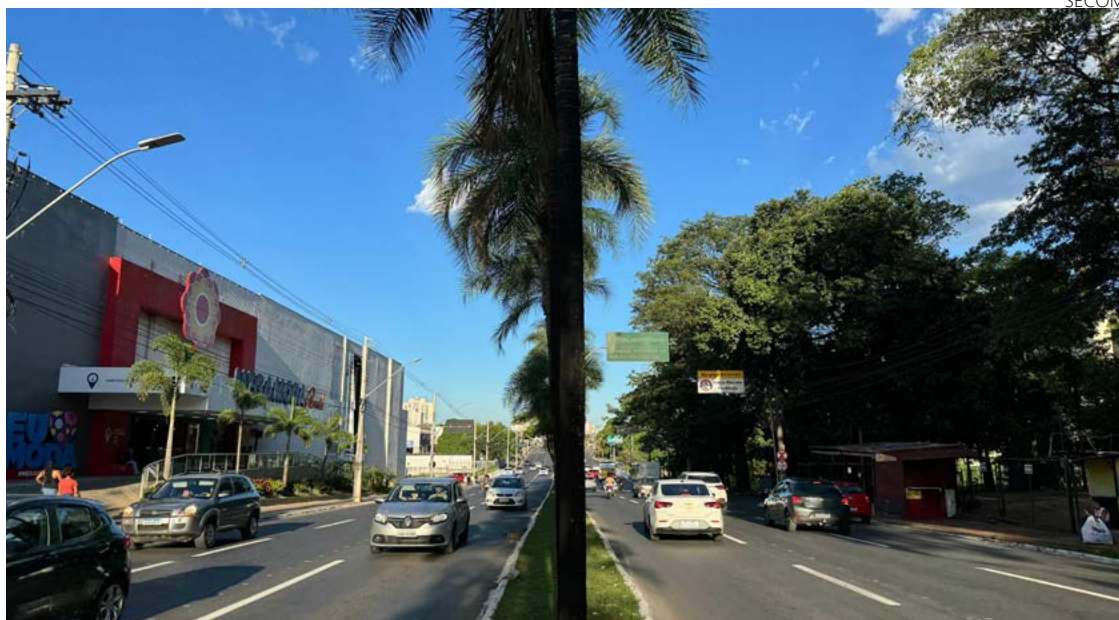
Obra foi lançada em setembro: intervenção recapeou 12 quilômetros de extensão
